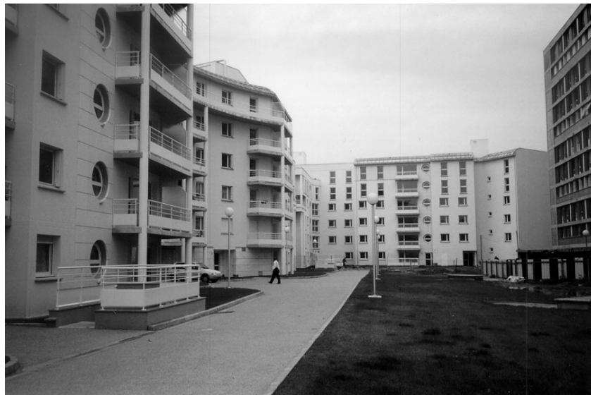
Vue d'une partie de l'ouvrage terminé, bâtiment 1 et 2
