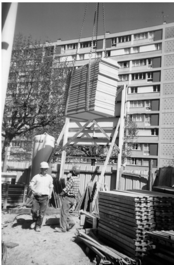
Déplacement de plaques avec la grue
