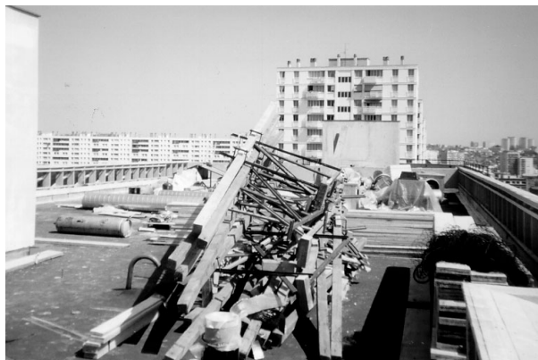
Vue de la terrasse du bâtiment 1, après enlèvement de la grue
