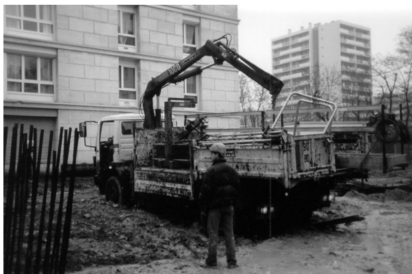
Camion embourbé et camion bloquant l'accès du chantier
