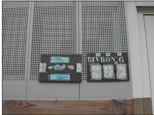
*Panneaux galva perforés assurant la luminosité*
