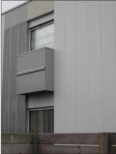
*Détails : Balcon en tôle pliée*
