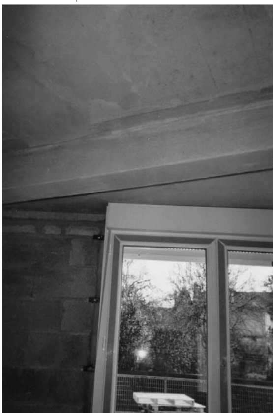
ouverture de fenêtre et retombée de poutre
