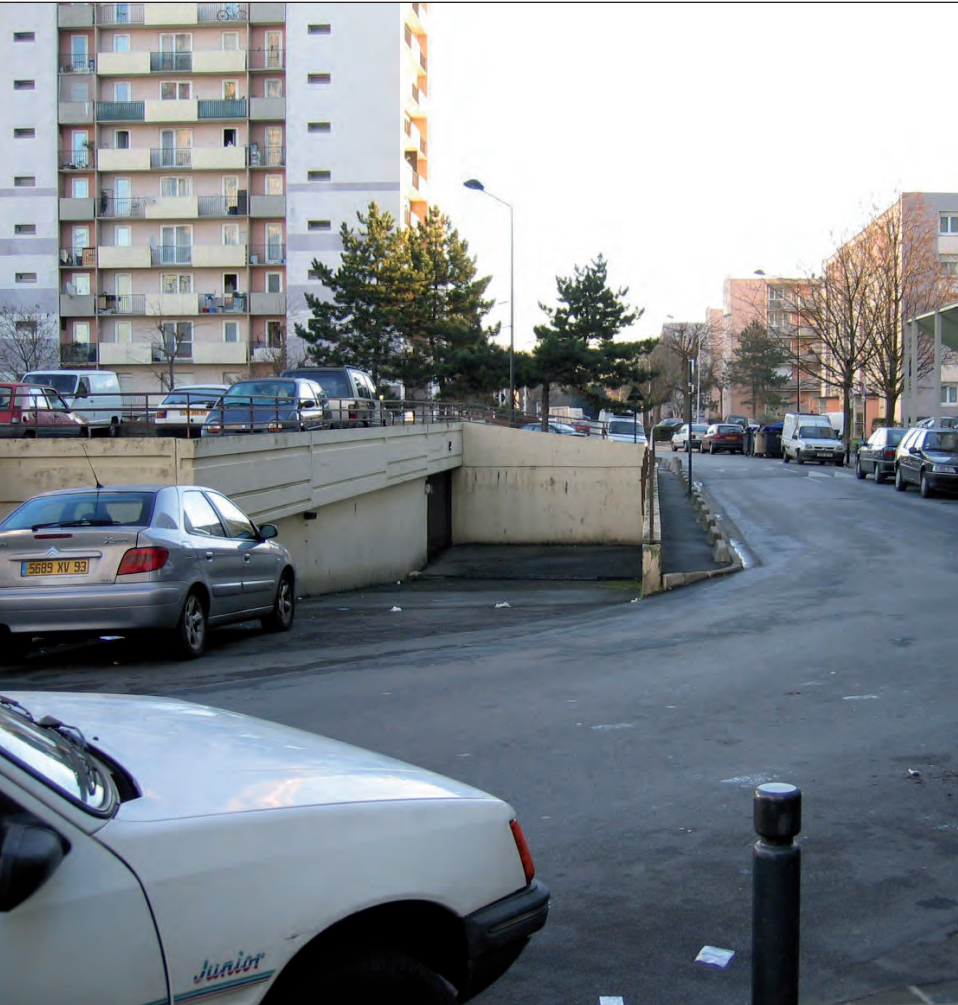
La dalle et les abords du parking P4 à la Courtille.
