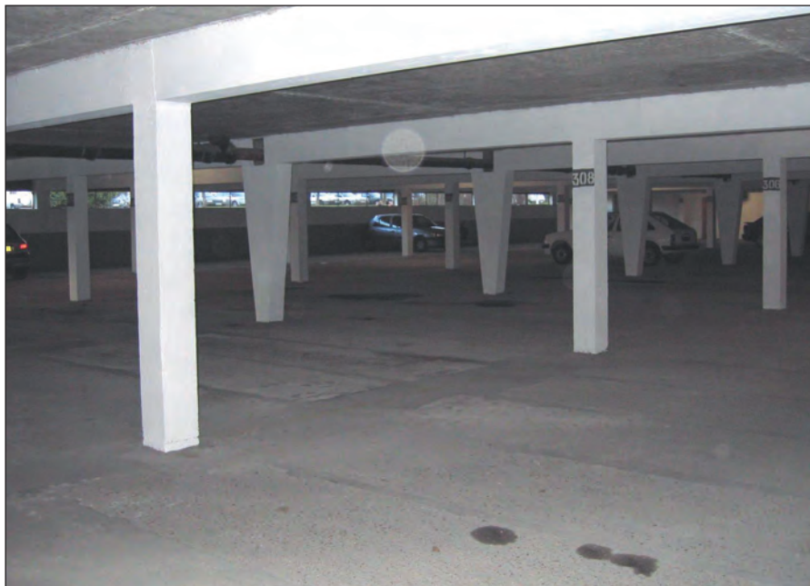
A la Courtille, le parking P1 rénové...
