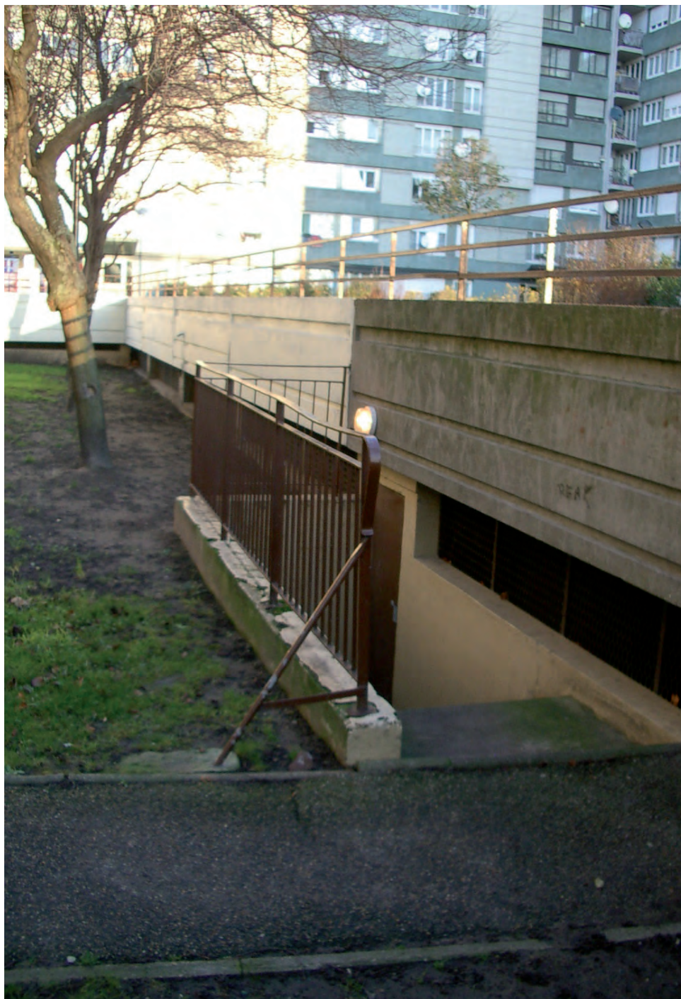
Sortie et dalle du parking P3, à la Courtille.
