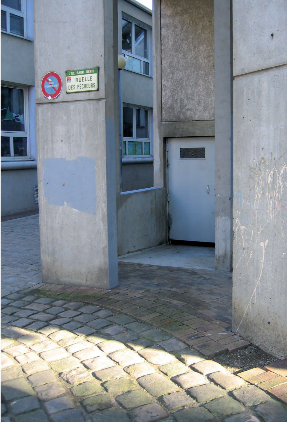
Le pavement d'accès au parking Bocage.
