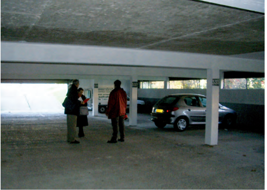
Le parking P1, éclairage naturel.
