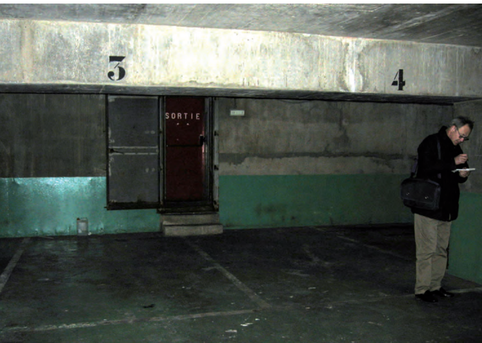
A l'intérieur du parking Lénine.
