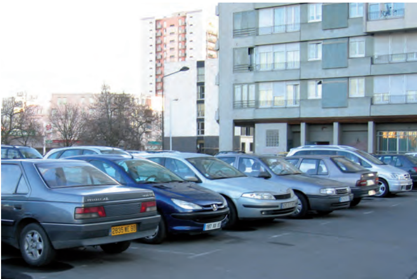
Le stationnement actuel sur la dalle de la Courtille.
