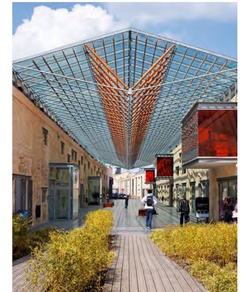
Passage couvert - Chais de Luze, Mog architectes
