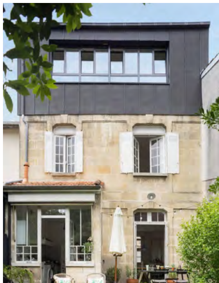
Espace de bureaux en surélévation
