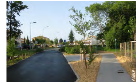
Voie mixte avec écluse à Pont-Saint-Martin
