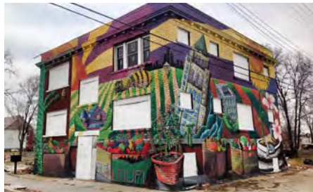
Surélévation, Bam architectes
