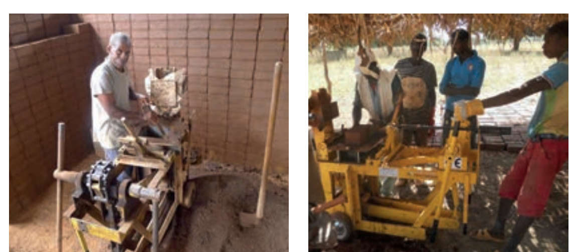
Photos d'autoconstruction à Mayotte et au Cameroun en BTC
