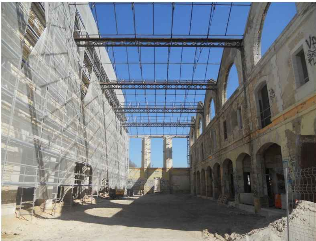
Rue intérieure couverte, au début du chantier de rénovation - SAS Darwin
