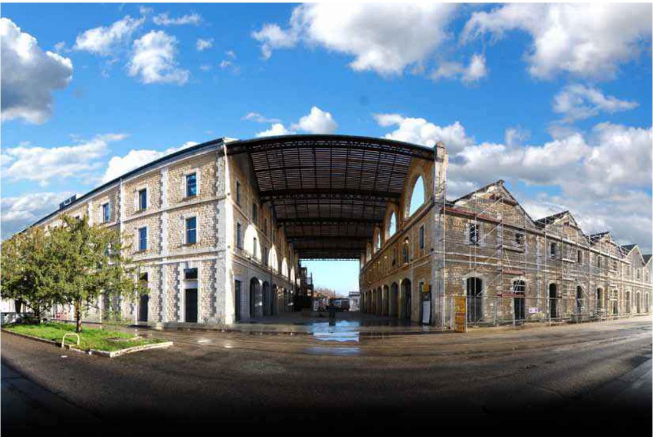
Vue sur les deux bâtiments principaux et la cour couverte – Source SAS Darwin
