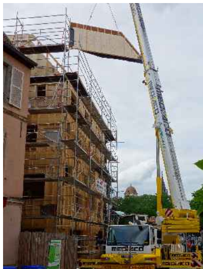
Chantier du projet Greenobyl – rue du Renard Prêchant
