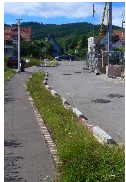
La "noue" finalement réalisée : une canalisation enherbée avec bordures
