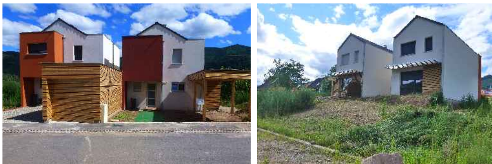
Les deux maisons "collées", vues de chaque côté
