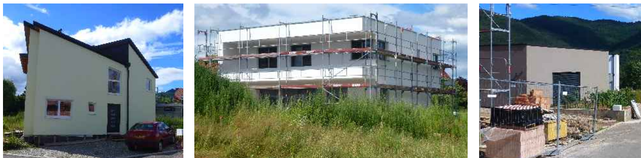
Les constructions des lots libres présentent une diversité architecturale
