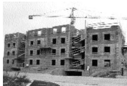
d'exécuter rapidement l'étanchéité et les remblaiements. Enfin, la grue, montée avant le démarrage des terrassements, a favorisé une réalisation des fouilles plus aisée qu'avec un camion<sup>3</sup>.
