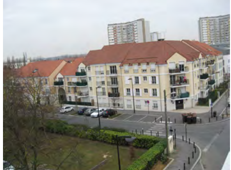
ZAC du Parc de Chenonceau - Promogim Ilot Champagne
