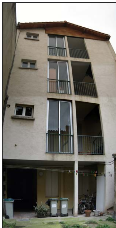
Façade sur cour (bâtiment A)
