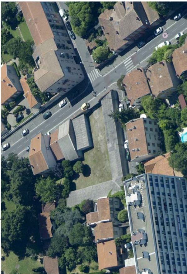
Vue du ciel depuis l'ouest
