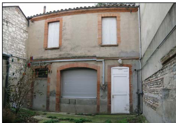
Façade de la chartreuse (bâtiment B)
