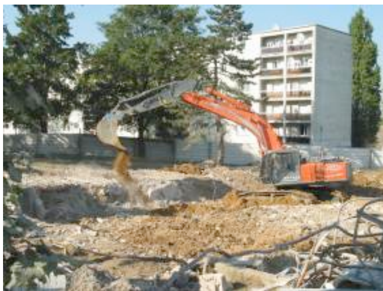
démolition 2005 le courrier de Mantes
