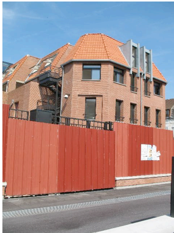
démolition et reconstruction angle Fontenoy 2006
