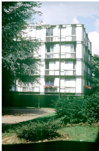
« c'est pas du béton ! » 2006
