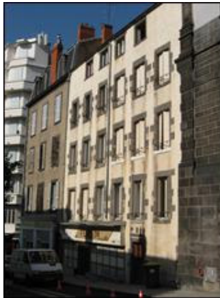
Rue Saint-Herem (pierres de blocage)
