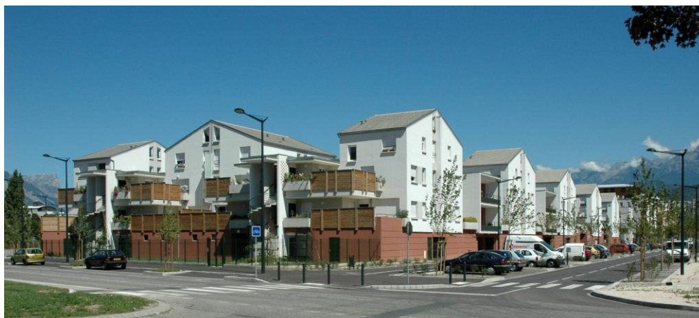
Une des deux opérations les plus denses : 133 logts/ha Grenoble, Les Allées de la Roseraie, 68 logements en accession, 2005, MO : Meunier Rhône-Alpes, archis : Groupe .
