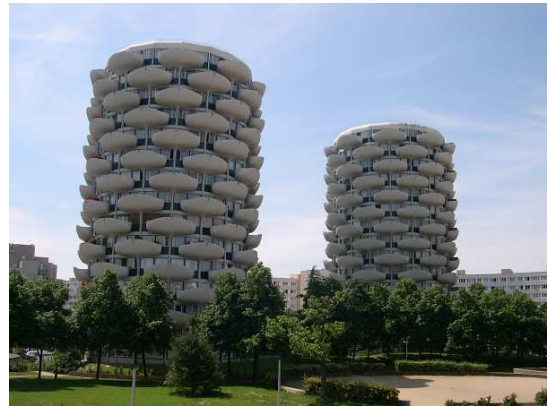
Figure 16 Cité des « Choux ». Créteil, Val-de-Marne (94), Ile –de-France, France. Photo : Vincent Le Quéré, 2004/ Structurae
