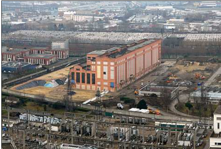
Figure 20 Ancienne Centrale EDF, site de la future cité du cinéma. Photo Plaine Commune SV/DR
