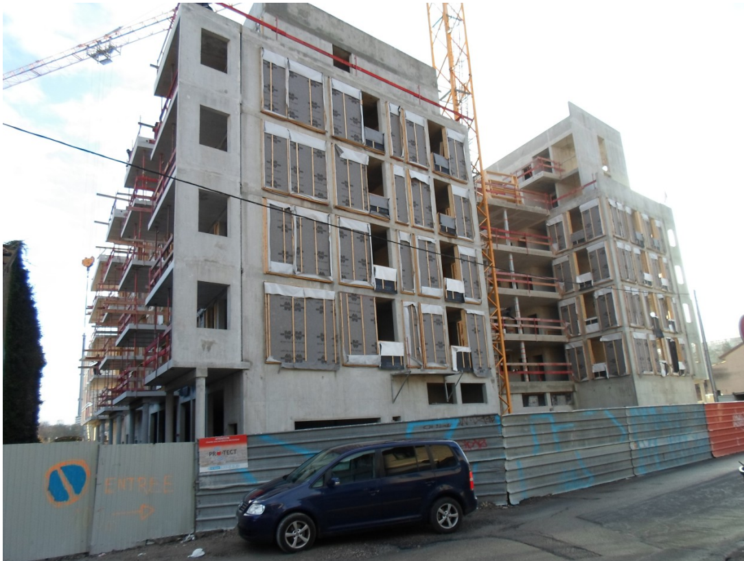
GRENOBLE-HABITAT : C1 –Ossature de la façade pendant la construction
