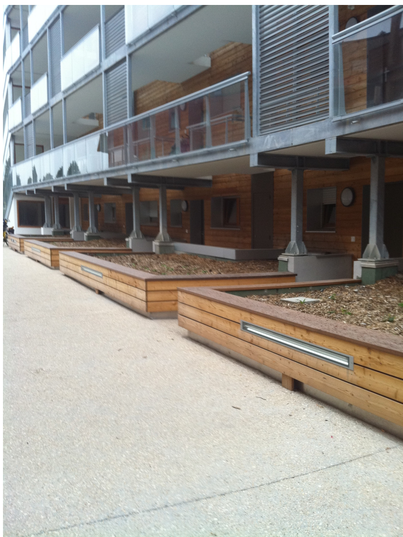
Immeubles B4, B6 après rectification et réaménagement des bacs –jardinière.
