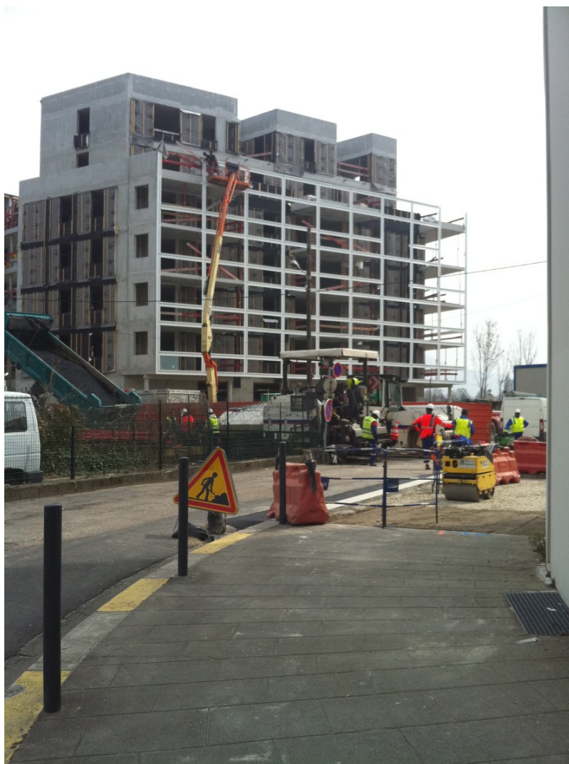
GRENOBLE HABITAT : C1 gros-œuvre terminé - avril 2013
