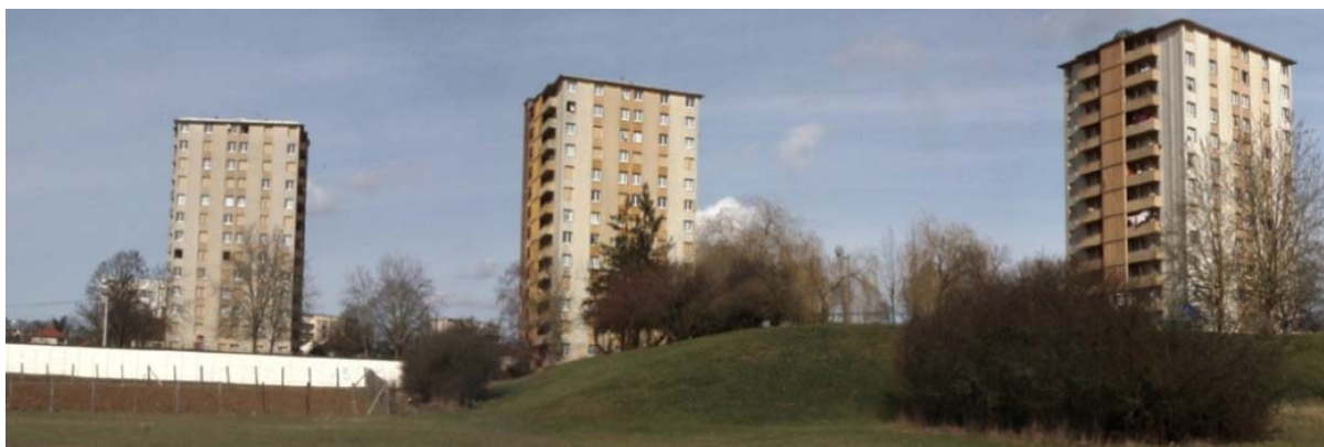
Les trois tours démolies le 30 juin 2007
