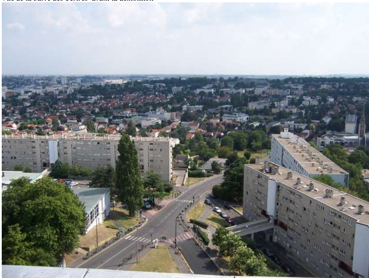
Vue de la barre des Tertres avant la démolition
