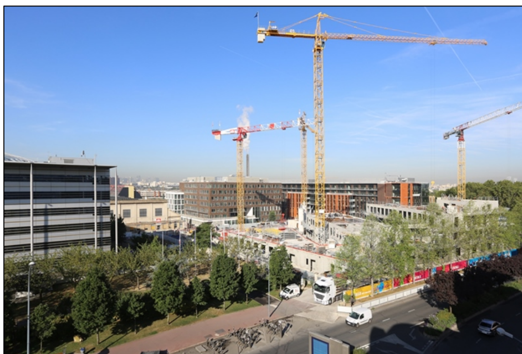
Figure 86 Construction de l'immeuble de bureau 'Les Docks en Seine' (septembre 2012)
