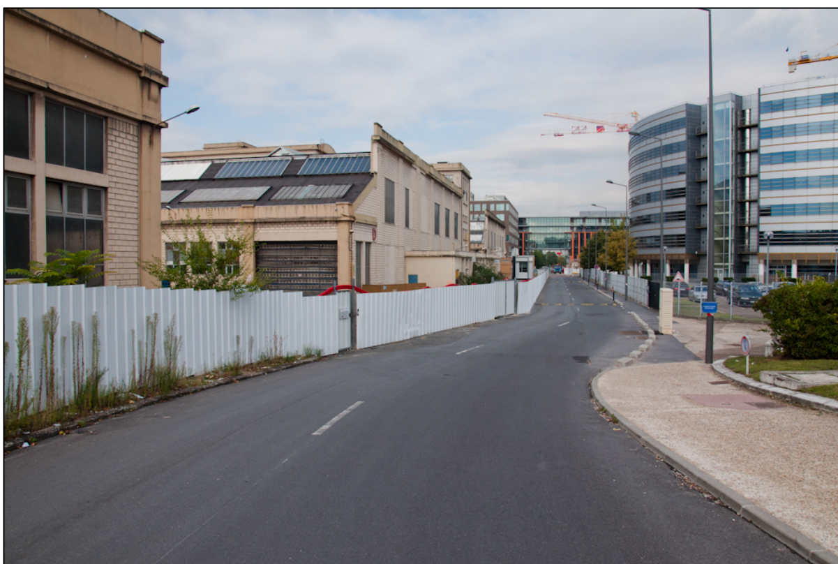
Figure 93 : L'entrée du secteur Dhalenne par la rue Paulin Talabot, avec les halles Alsthom (à gauche) et le siège d'Alstom Transport dit "Omégat" (à droite), les bureaux Sigma (au fond)
