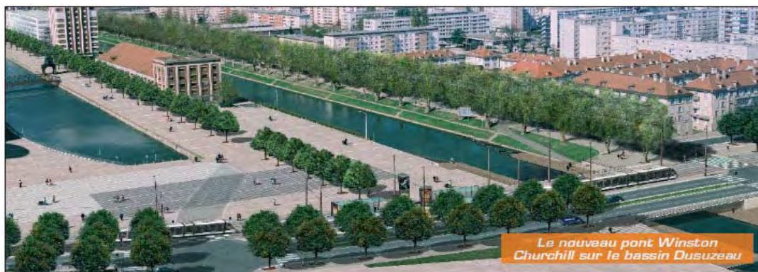
Figure 16 : Le nouveau pont Winston Churchill sur le bassin Dusuzeau
