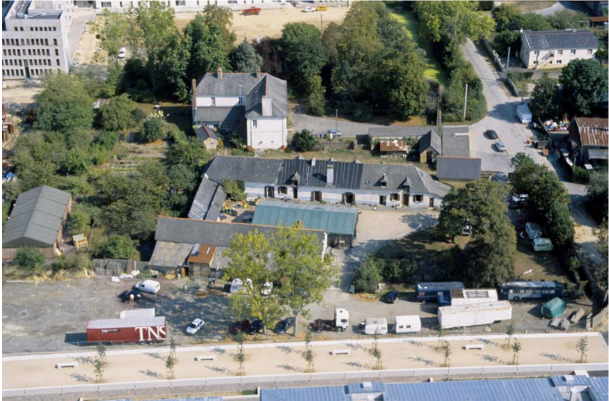
La ferme et le manoir du Haut-Bois sont deux patrimoines communaux qui marquent les limites du nouvel ensemble.
