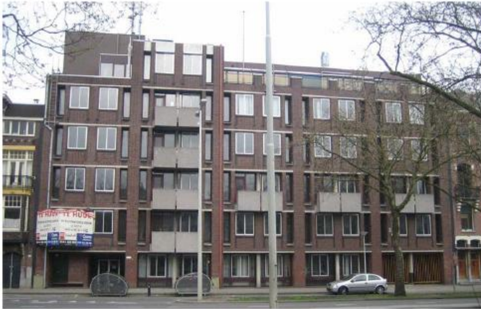
Bureaux vacants sur lesquels une de transformation partielle a été réalisée
