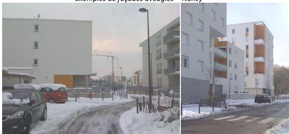
Façades et rez-de-chaussée sans ouverture à Teisseire
