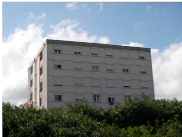
Figure 35: Logement collectif des Bons Enfants (façade Sud).
