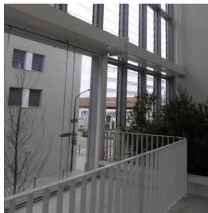
Photos 1 - 2 : Ventelles façade est vue de l'extérieur et façade sud vue de l'intérieur.
