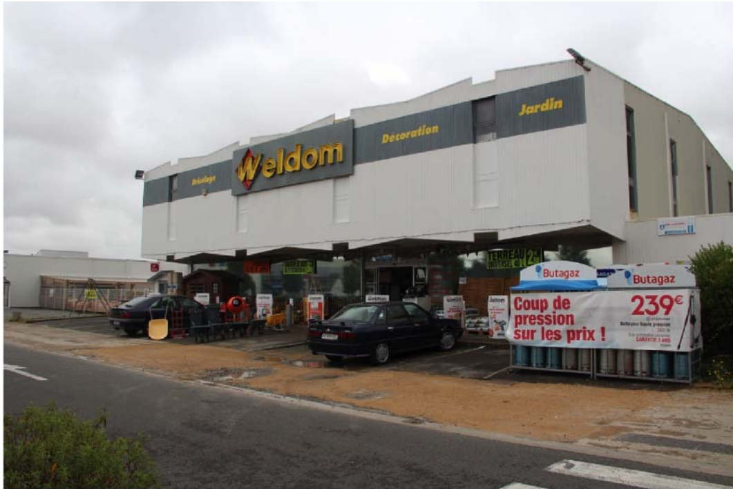
Vue extérieure du magasin Weldom de Legé
