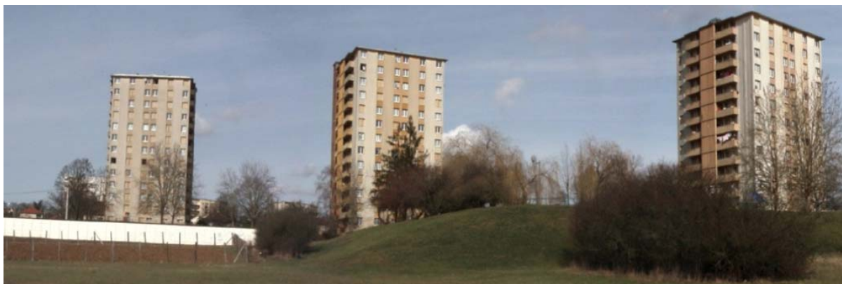
Les trois tours démolies le 30 juin 2007
