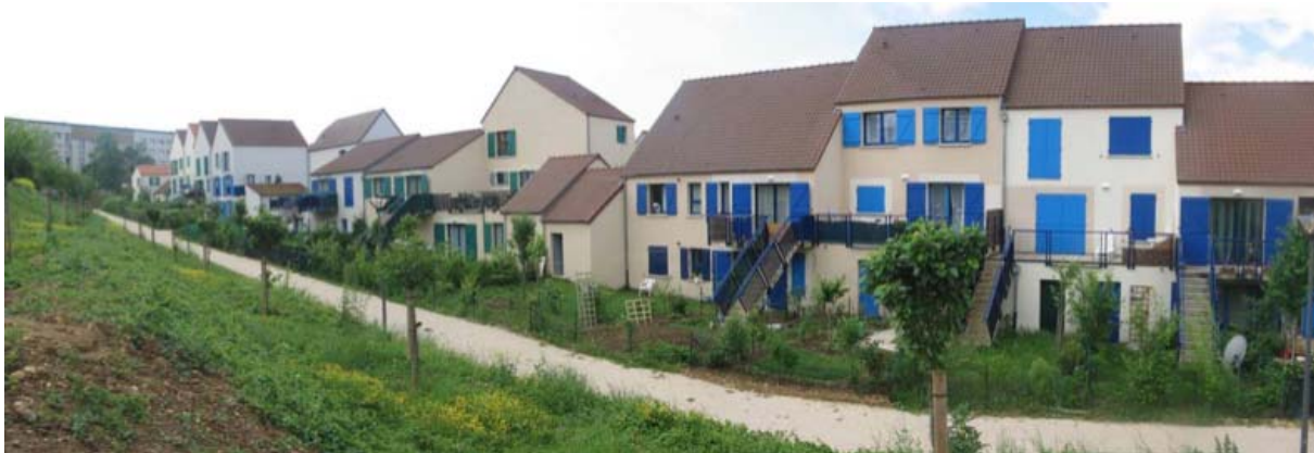
Vues de la première tranche construite par l'architecte Lucien Kroll
