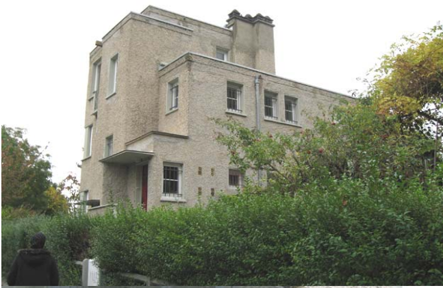
Figure 49. Un des principaux points d'achoppements du projet a été la réfection partielle des enduits « mignonette » imposée par l'ABF et subie à la fois par l'architecte (qui aurait préféré une réfection totale et la pose d'un isolant extérieur) et par les habitants.
