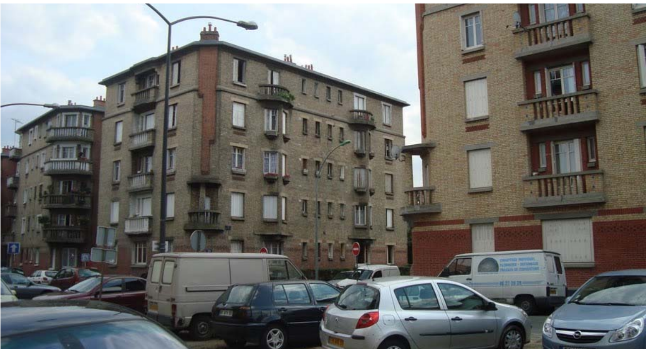
Figure 4 : différence entre la brique nettoyée et non nettoyée, V. F. 2010
