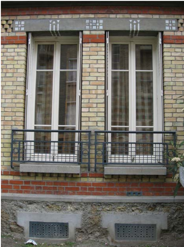
Figure 5 : les fenêtres en bois originales sont remplacées par des menuiseries en PVC, à droite, sauf sur la place Marcel Pointet où elles demeurent en bois, à gauche. V.F. 2010.
