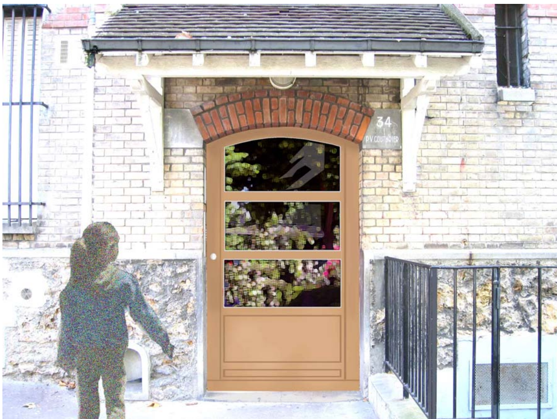
Figure 6 : les portes de hall. Source J. BOIDOT.
