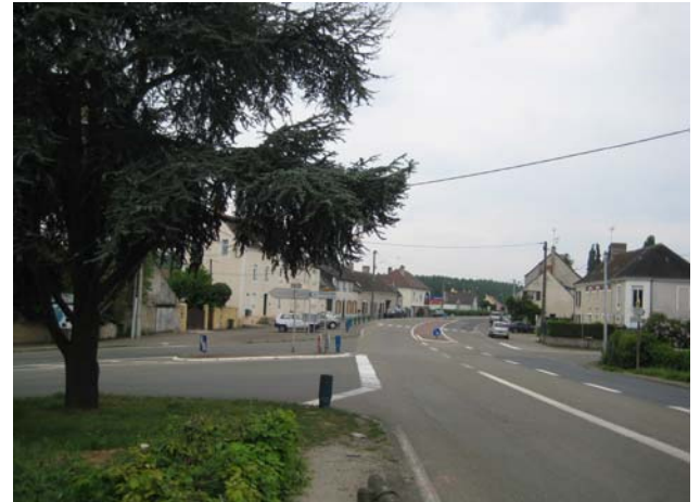
Ci-dessus : le carrefour entre les 2 voies menant vers les ponts. (Vue vers sortie direction Le Mans)
