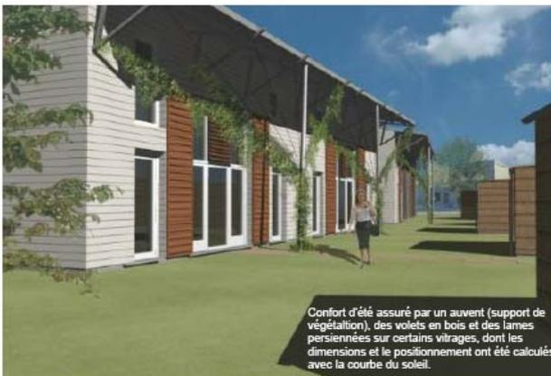
Confort d'été assuré par un auvent (support de végétation), des volets en bois et des lames persiennées sur certains vitrages, dont les dimensions et le positionnement ont été calculés avec la courbe du soleil.
