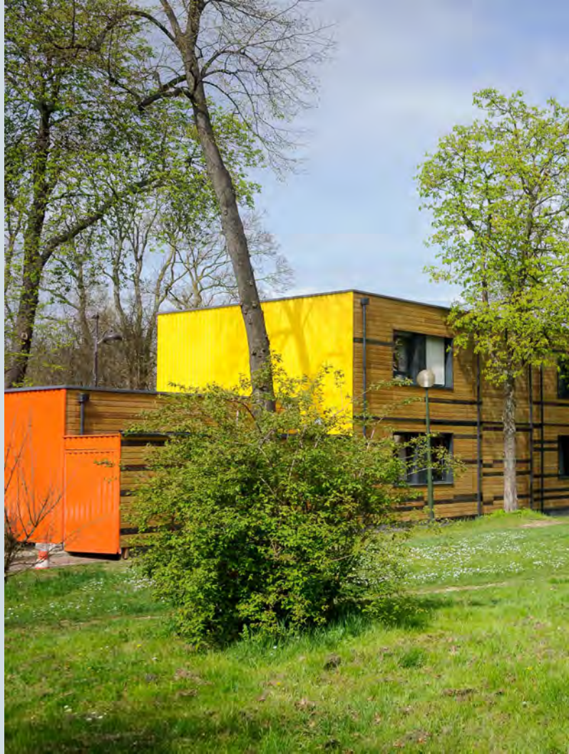
Centre d'hébergement d'urgence à Paris 16 ème © AIR et Moon architecture © Terra, MTES/MCT
