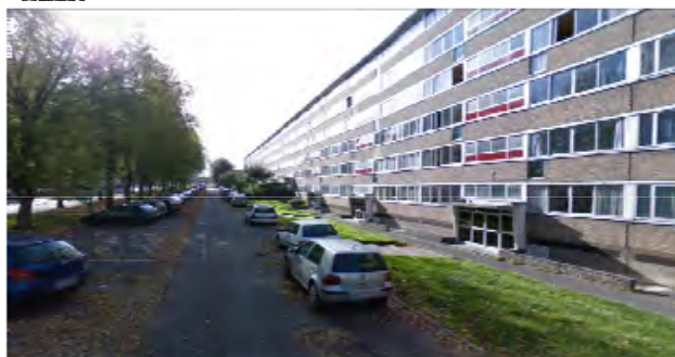
APRÈS : FAÇADE PRINCIPALE
