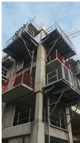
Ratio Coût / Bénéfice : nous avons réalisé pour cette opération l'ensemble des rotations au moyen de la maquette numérique préalablement à la réalisation sur site et avec des outils coffrants spécifiques créés en IFC. Cette démarche nous a conduit à diviser par 2 notre investissement initial pour l'achat de ces outils en combinant habilement la réalisation des voiles de façades et de refend. Nous avons ainsi économisé 32 000 €HT.
