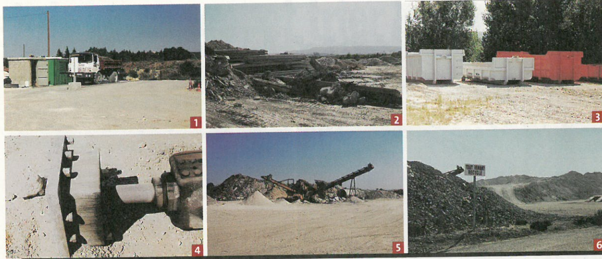
Sur le site d'une ancienne décharge à Pujaut, l'entreprise Bernardoni TP a créé une plate-forme de stockage et de traitement des déchets: arrivée des déchets (1), stockage (2), tri (3), concassage des éléments en béton (4), criblage (5), et stockage avant départ pour réemploi (6).
