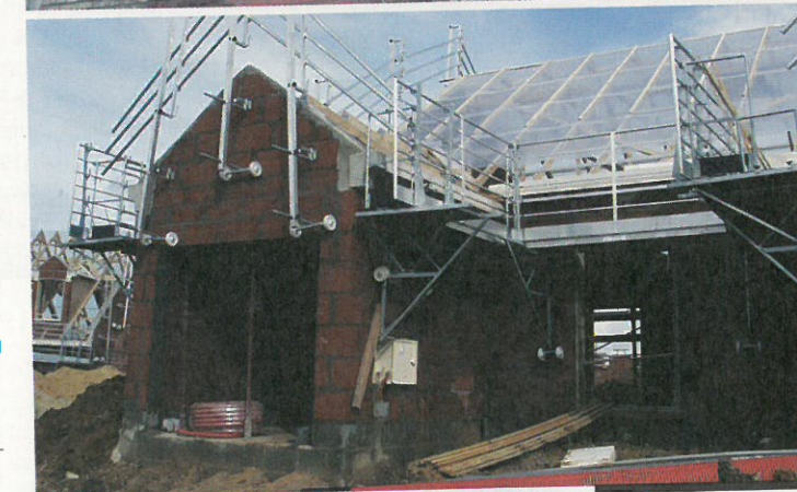
L'accrochage des deux premières consoles, puis du plateau d'échafaudage, se fait aisément depuis le sol par des compagnons. Les extensions se font selon le même principe.
