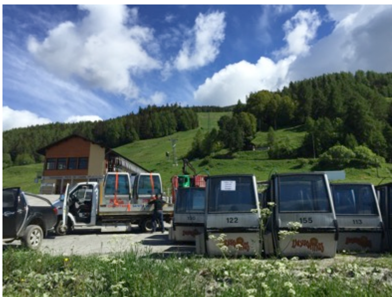
Figure 8. La remontée mécanique de la piste de l'Ours, en cours de transformation
