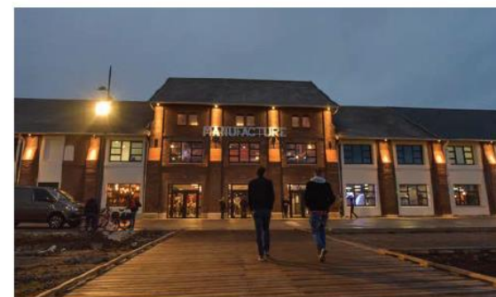
La Manufacture à Dieppe (Seine-Maritime)
