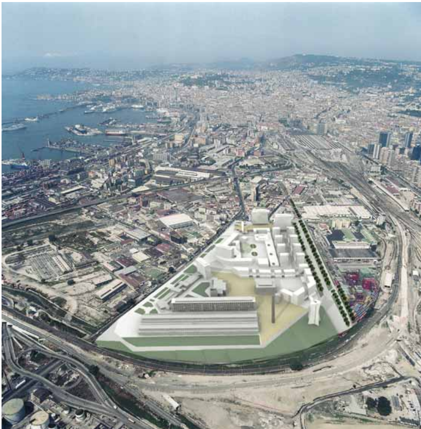
Figure 11 : Vue du site et projet de commissariat
