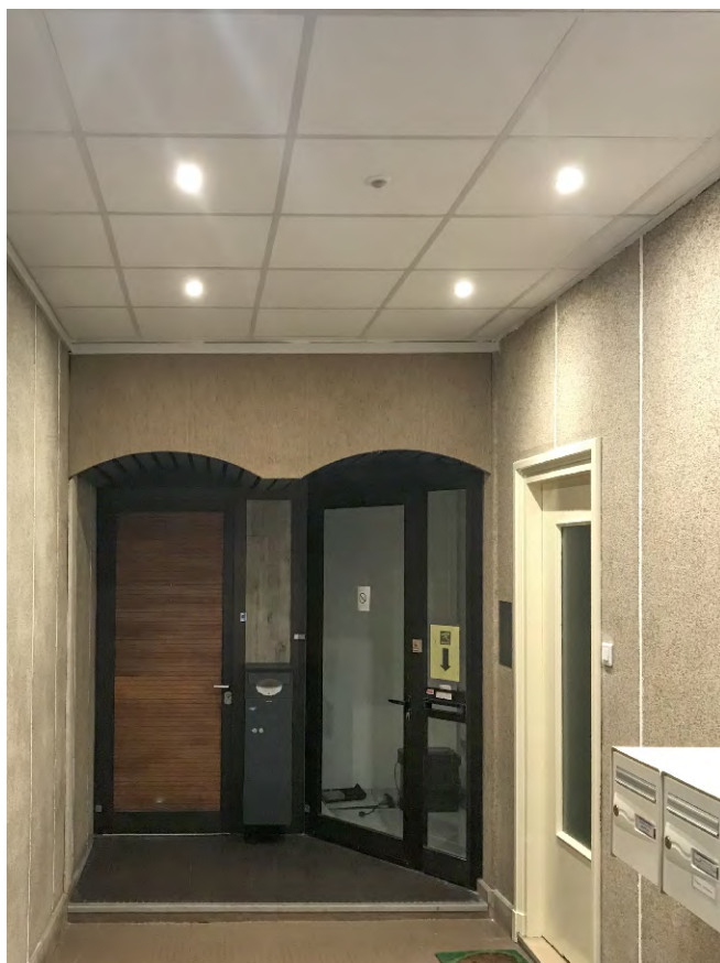
Hall d'entrée : Isolation du plafond
