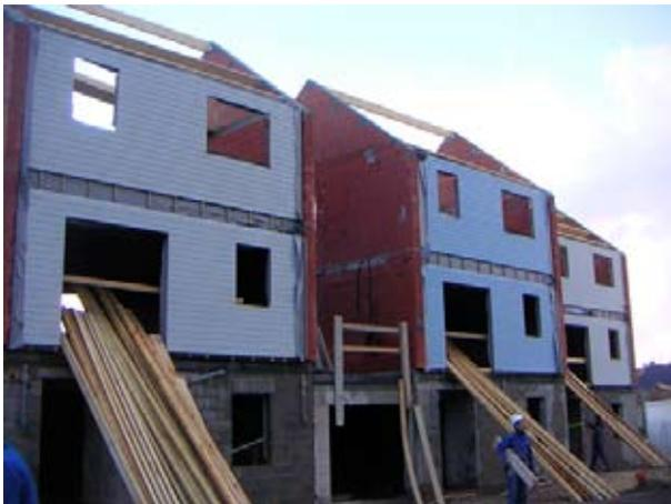
Mise en place des éléments en bois préfabriqués de la façade
