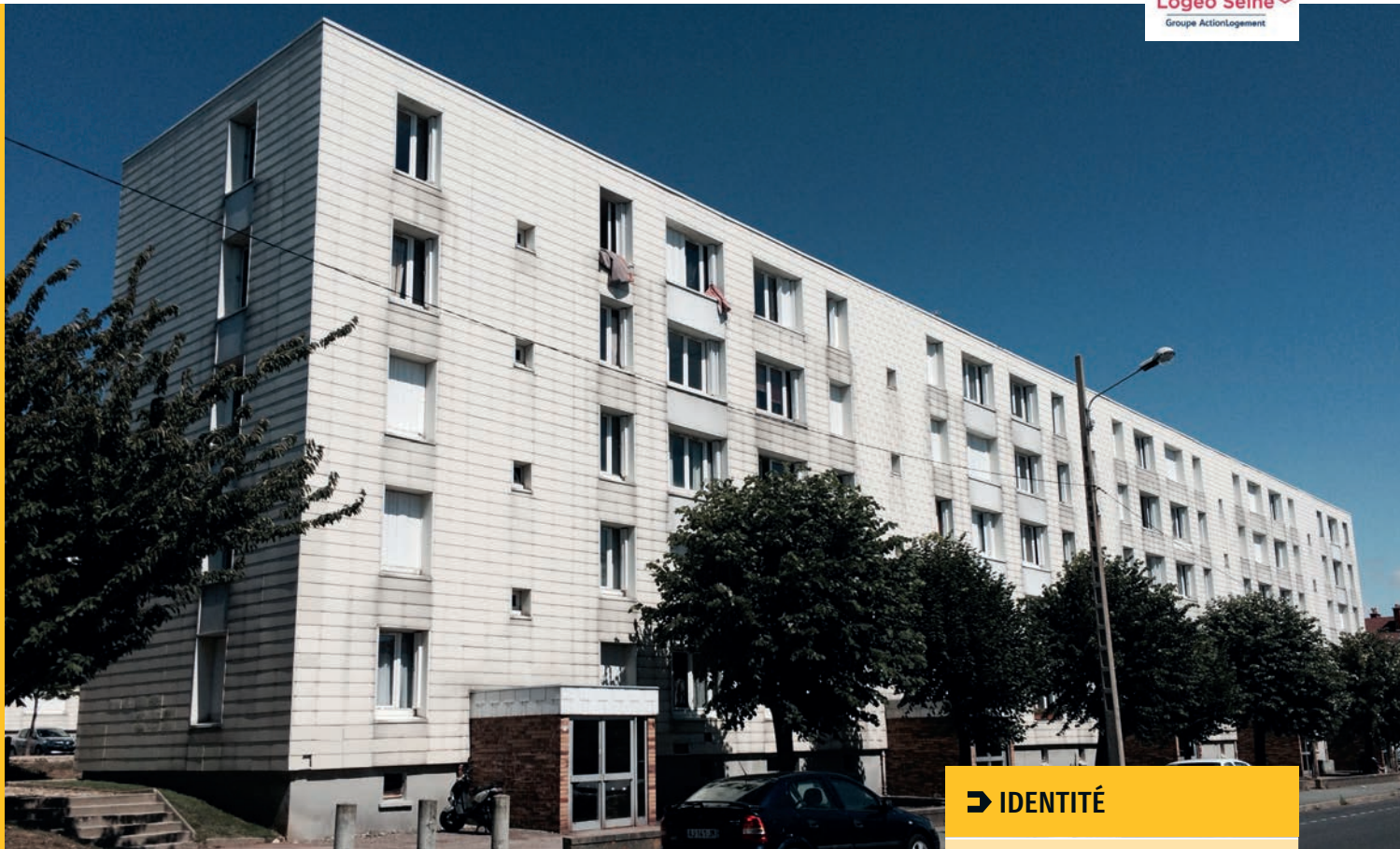
▲ Vue sur le bâtiment B depuis la route du Cap
