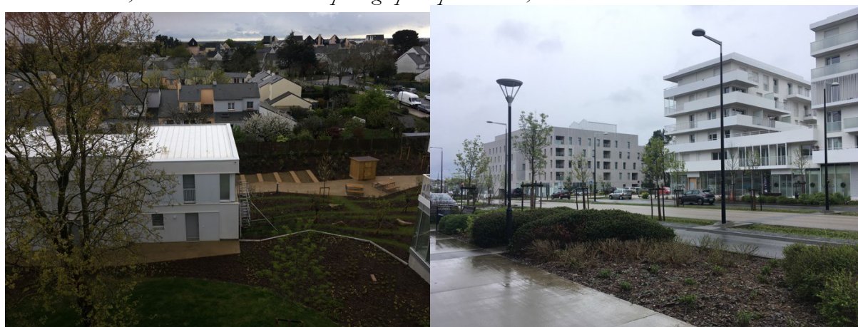
Figure n°4. Une architecture compacte ? Photographies de programmes immobiliers localisés dans la ZAC Charles Gautier, Saint-Herblain. Source : photographies personnelles, 2022.
