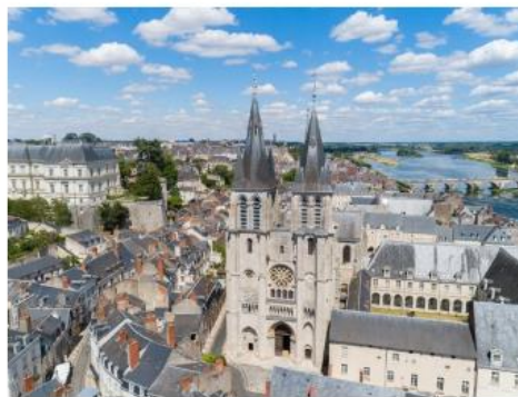
^Restauration de l'église Saint-Nicolas (2020-2026)
