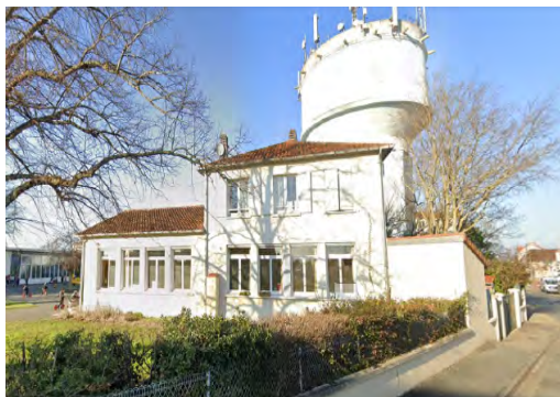
Ancien logement de concierge de la halle des sports, Route de la Cassette, Poitiers (Propriété de Grand Poitiers CU). Libre d'occupation
