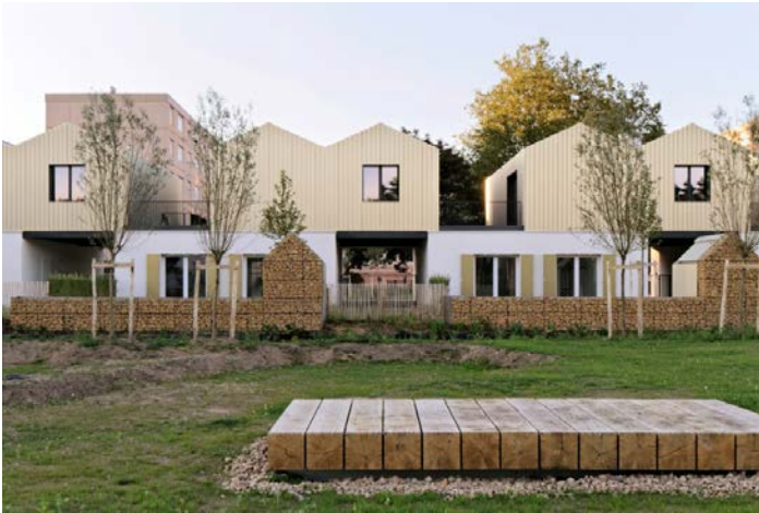
34 LOGEMENTS LOCATIFS, ÉCO-CITÉ LA GARENNE, FOURCHAMBAULT
