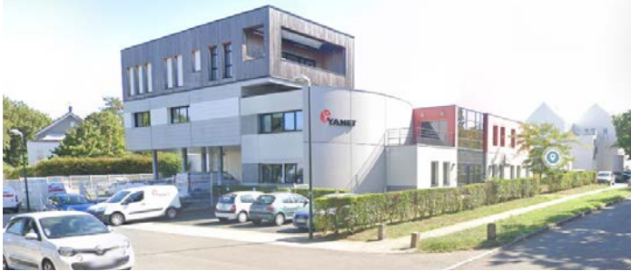
RÉAMÉNAGEMENT DE L'OFFRE IMMOBILIÈRE PAR SURÉLÉVATION, ENTREPRISE YANET, NANTES
