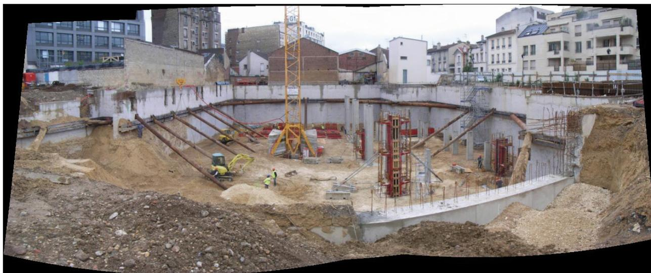
*La construction du gymnase et d'un parking en sous-sol a nécessité le creusement d'une fosse / Photo Ateliers 234*
