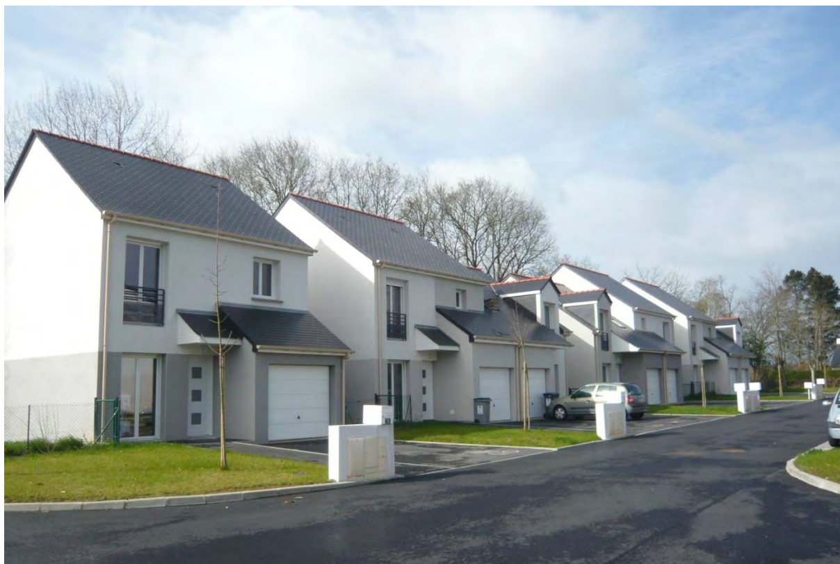
Opération de La Maison Blanche : maisons accolées en VEFA
