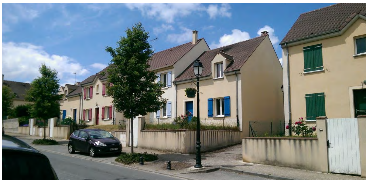
Autre vue du clos Lampezard (maisons de ville en accession) CCMI avec architecte coordinateur
