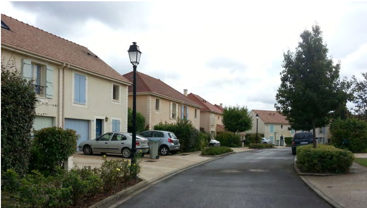
Opération du Moulin Rieux : maisons « à l'américaine » réalisées entièrement en VEFA
