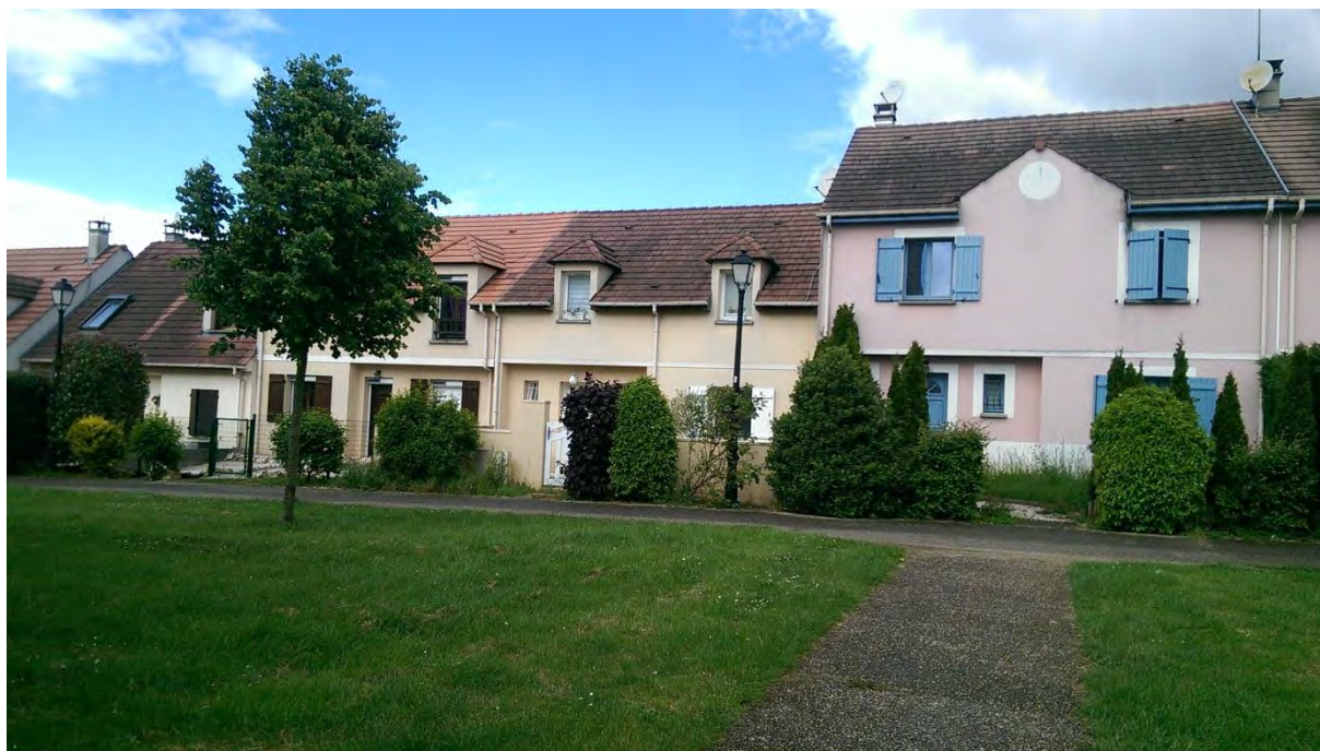
Opération « Les chaudrons » : maisons de ville en CCMI avec architecte coordinateur
