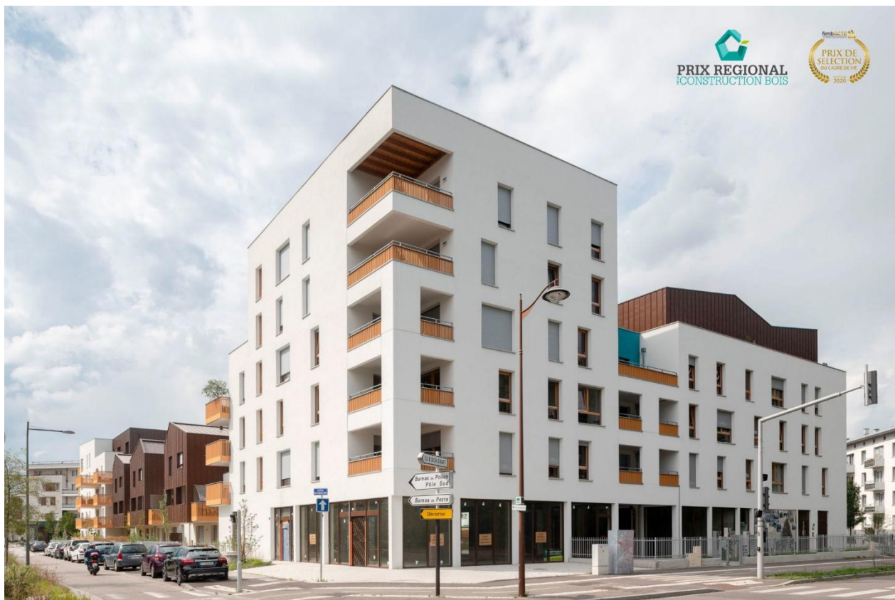
Illustration 3 : Vue sur un des deux bâtiments collectifs – Source : Agence d'architecture K&+Architecture Globale
