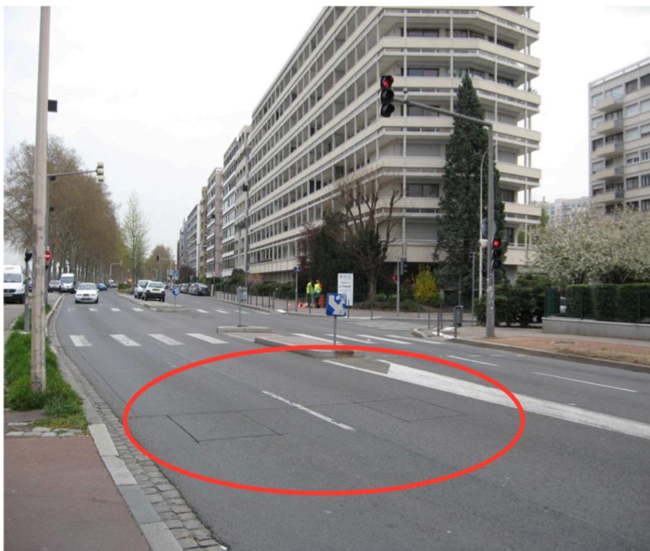
Illustration 2 : Boucles à induction détectant le passage ou la présence d'un véhicule sur la chaussée
