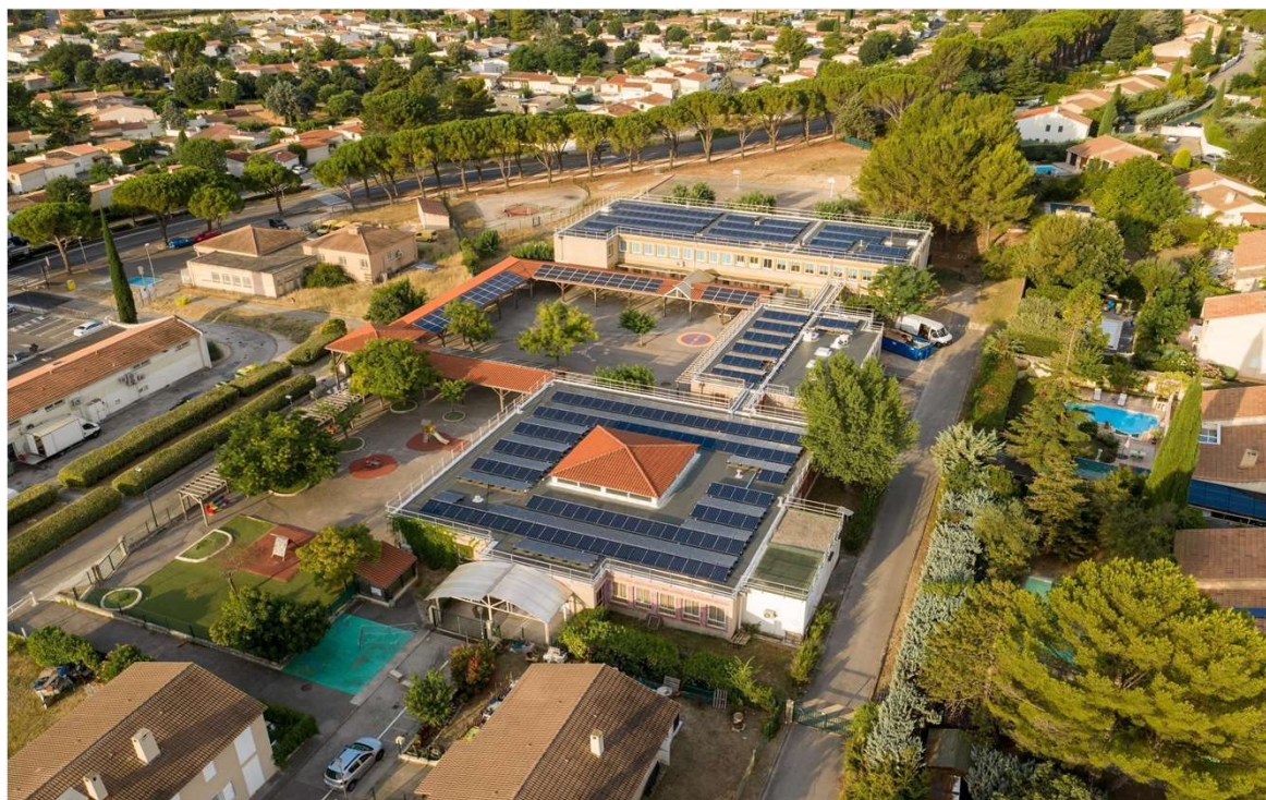
La centrale du groupe scolaire du Petit Lac à Cabriès (©Petillot)
